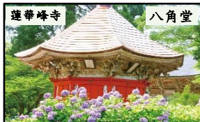
弘法堂・金堂等の国の重要文化財が多く点在する蓮華峰寺。アジサイ寺としても有名。
